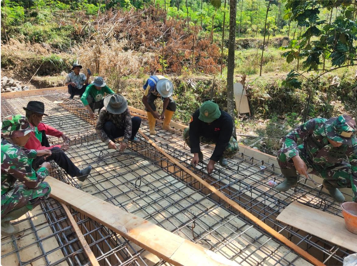
Di dalam kegiatan pengecoran Kodim 0720 Rembang Pendim mengatakan, pengerjaan pengecoran bersama-sama baik anggota satgas TMMMD bersama warga, sebelum melakukan pengecoran dilakukan perangkaian besi setelah itu dilanjut pengecoran pada lantai jembatan.
